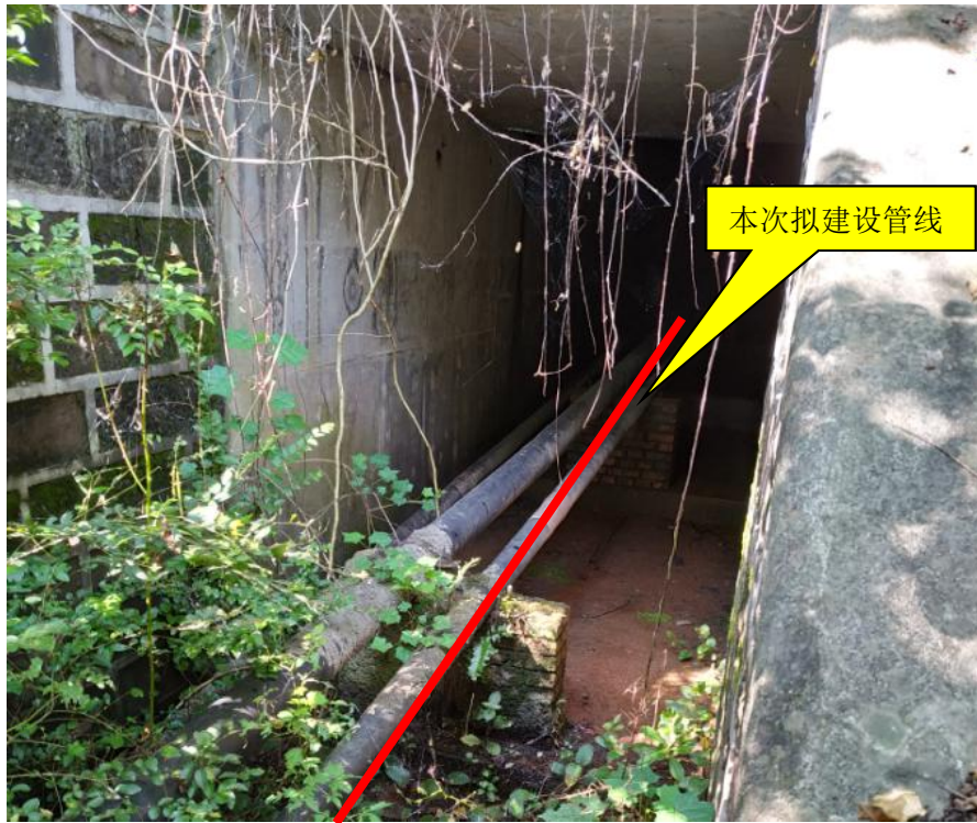
图 1-7 拟利用燃气管道专用函穿越铁路
